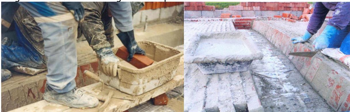
La pose des briques de la voûte peut être disposée en spirale dans le sens contraire de l'aiguille d'une montre. Souvent cette spirale démarre sur le pied droit (ou rive ou encore côté du four), c'est à dire, des carreaux assez épais disposé sur le pourtour du four.
