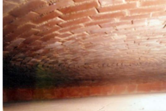
La voûte ronde peut être aussi disposée en assise paire et impaire non spirale, superposée.
